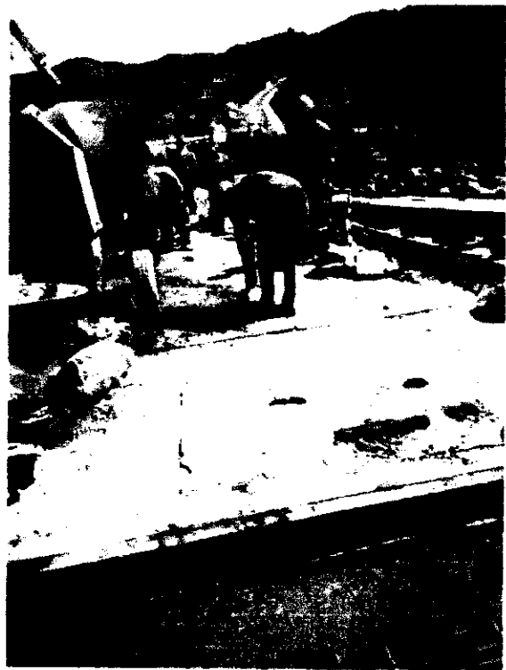
IMAGEN 6. VACIADO DE JUNTAS TRANSVERSALES Y LONGITUDINALES
