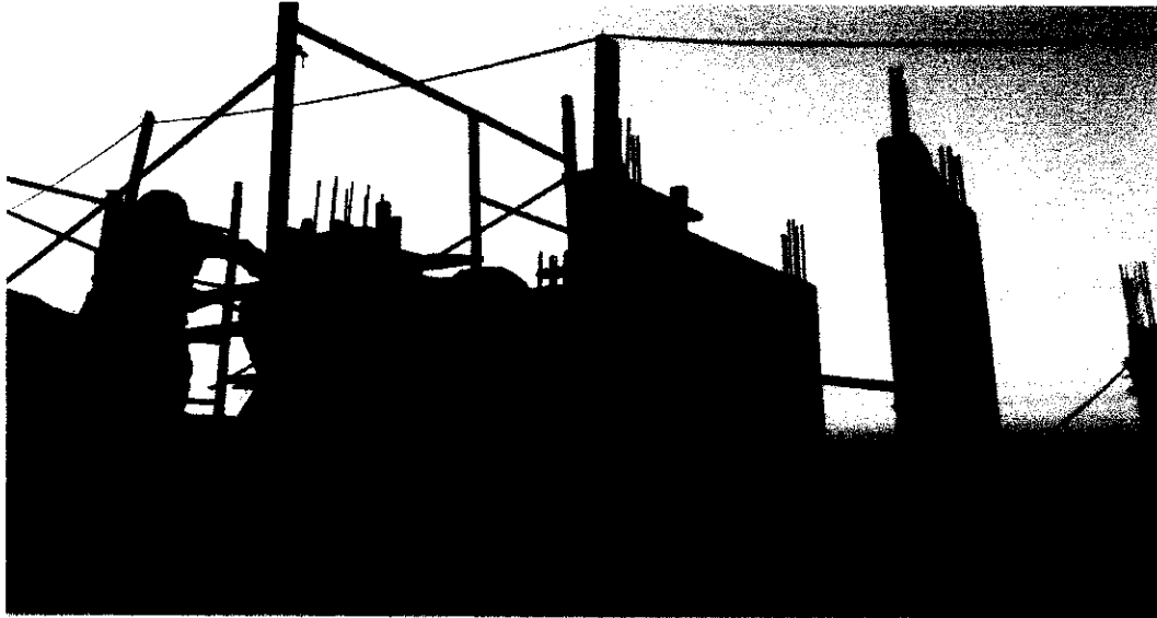
Ilustración 9.-Columnas en caseta de vigilancia
