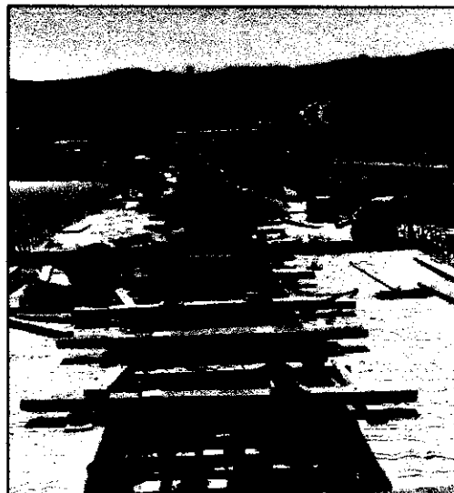
Ilustración 4.-Fundido de juntas longitudinales y transversales.
